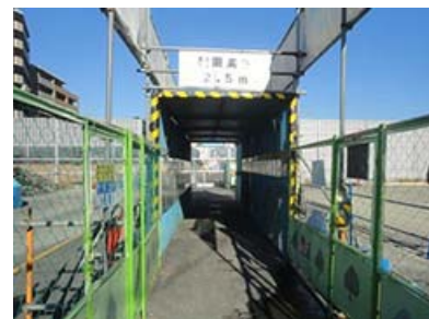
外環道 田尻地区歩行者専用横断通路
