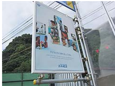
十九洲第一トンネル工事現場
