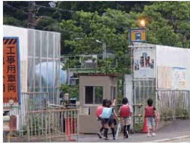
開発製品を設置した工事現場
